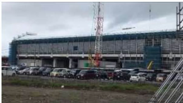
↑ 建設中の新幹線長崎駅
